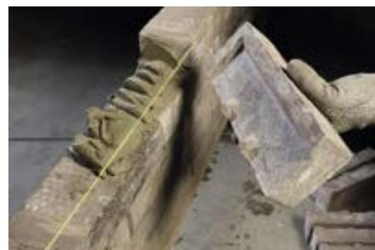
Dans un contexte où la demande se fait de plus en plus pressante pour réduire le temps de construction et avoir des modes constructifs efficaces, on a vu apparaître des éléments de murs préfabriqués et des techniques de collage de blocs.
