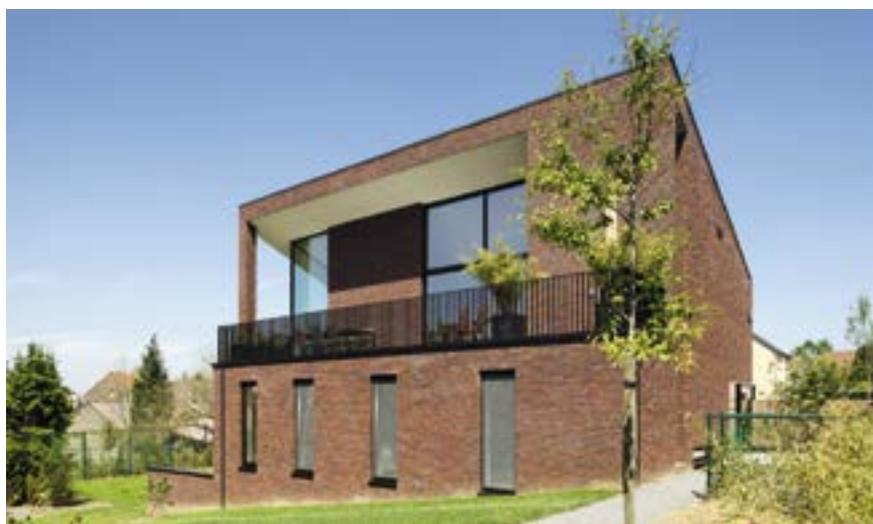
La maçonnerie est mise en œuvre à joints minces, en appareillage sauvage. L'architecte a choisi une brique avec des teintes fortement nuancées. La maçonnerie de parement s'accorde ainsi avec l'esprit du projet : à la fois massive et raffinée. Ce raffinement se retrouve également dans le soin apporté aux détails comme la découpe des briques de façon à avoir des assises horizontales
