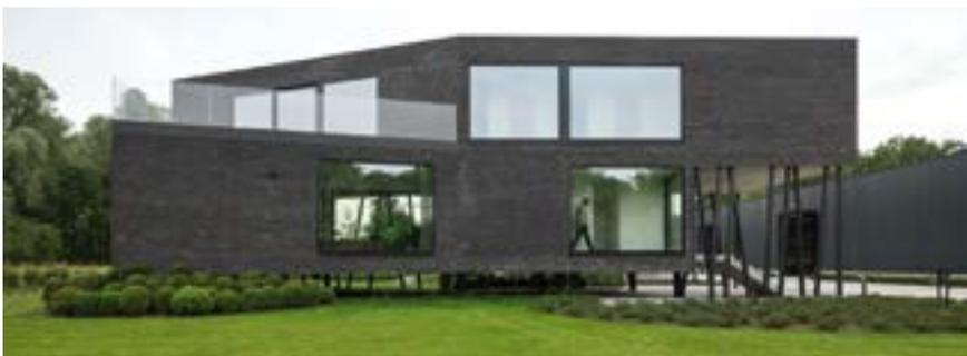
La particularité principale du bâtiment est qu'il est détaché du sol. Les principales raisons sont de pouvoir éviter les risques d'inondations et d'alléger la présence du bâtiment dans son environnement. Cela a été rendu possible par une structure en acier. A ses deux extrémités, la construction sur
