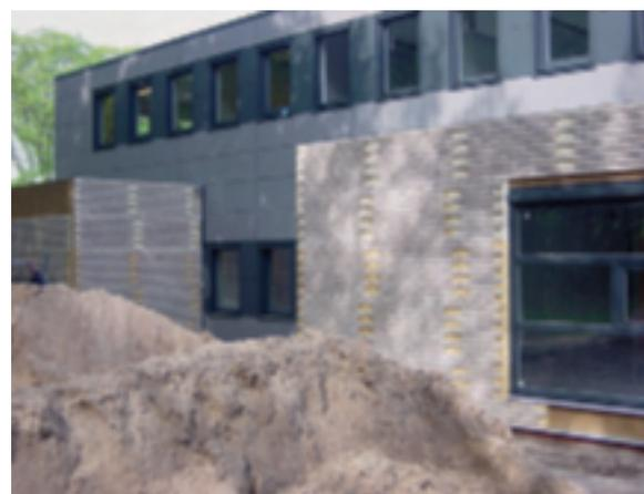
Pour certaines applications, on peut avoir recours à des panneaux préfabriqués avec des plaquettes de terre cuite qui se fixent sur une sous-structure. Les plaquettes sont collées sur un panneau résistant à l'humidité et conditions climatiques. L'appareillage de maçonnerie ne joue ainsi plus aucun rôle dans la stabilité de la façade et l'architecte a totale liberté dans le dessin des appareillages.
